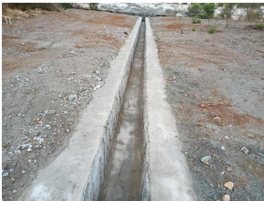
图 2.4-15 坝面纵向排水沟
