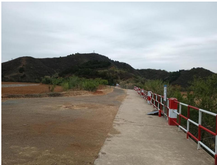
图 2.4-5 和尚峪尾矿库西副坝现状
