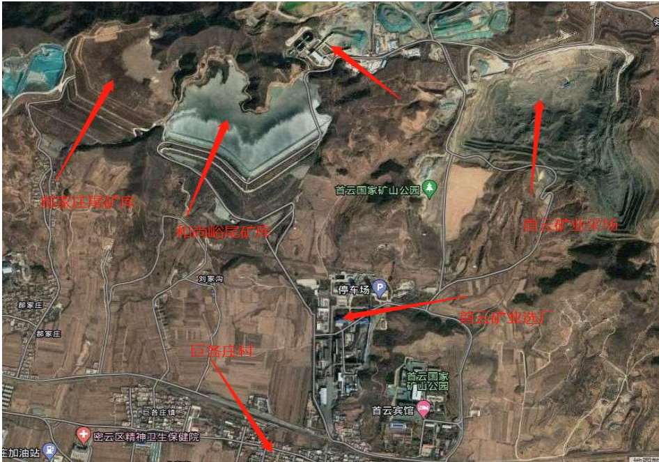
图 2.4-4 尾矿库航拍图
