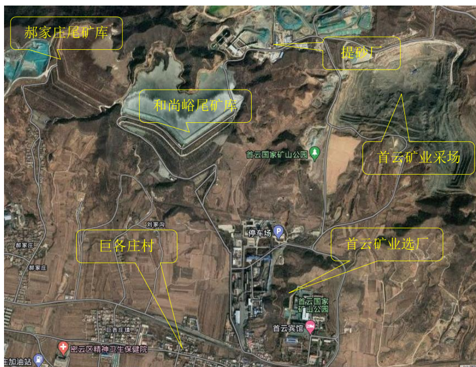
图 2.2-1 和尚峪尾矿库库区及周边环境
