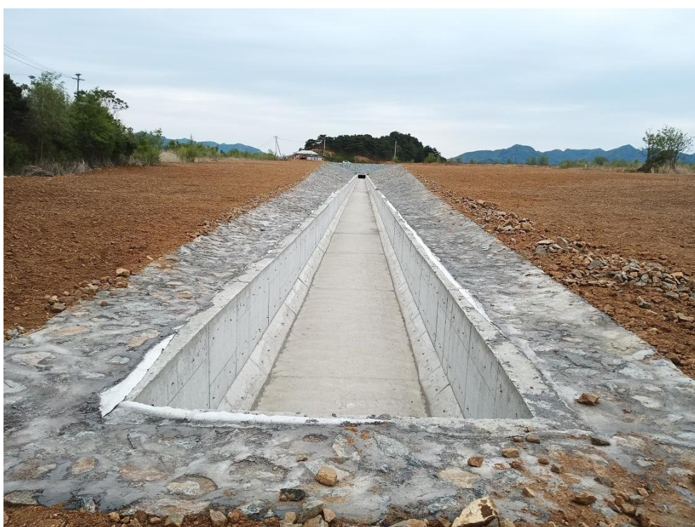
图 2.4-10 新建溢洪道（库内段）
