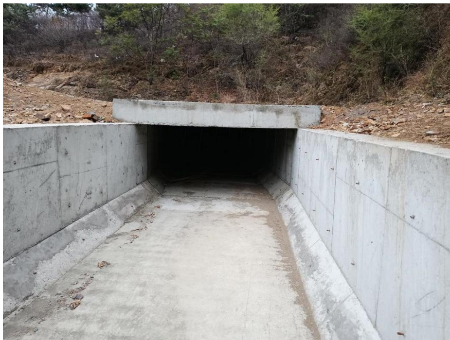
图 2.4-11 新建溢洪道（库外段）
