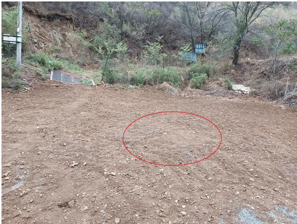
图 2.4-14 11#排水井封堵位置
