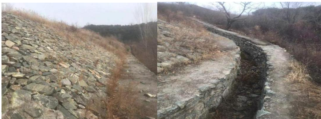
图 2.4-1 和尚峪尾矿库西侧初期坝及排水沟闭库前现状图
