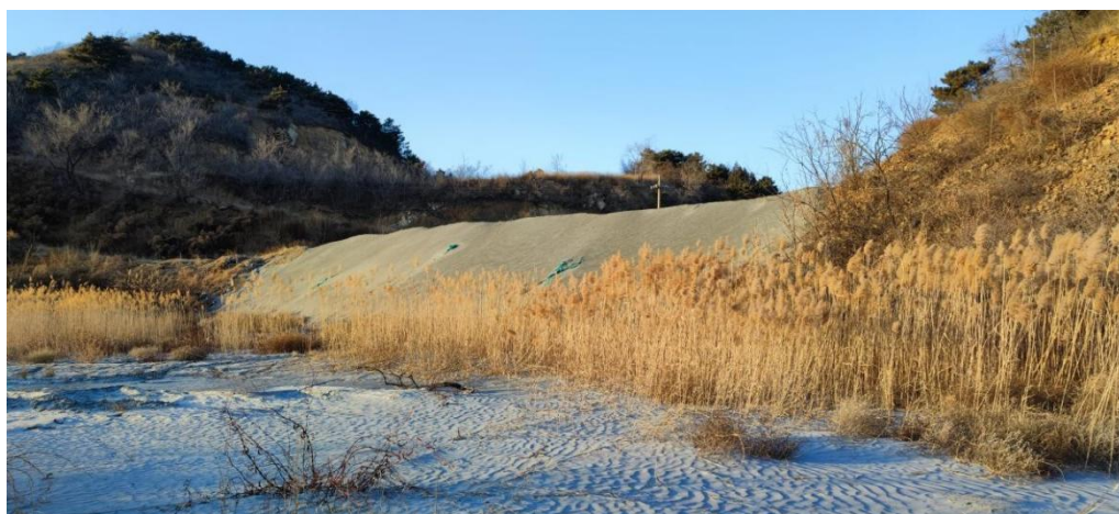
图 2.4-4 和尚峪尾矿库北副坝闭库治理前现状图
