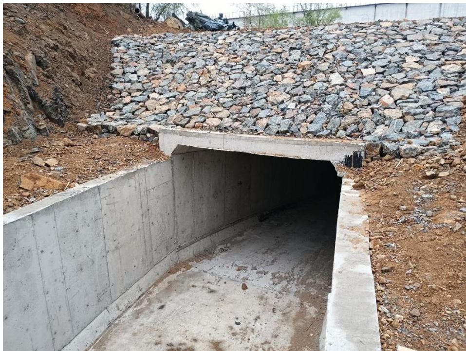
图 2.4-15 新建暗涵入口
