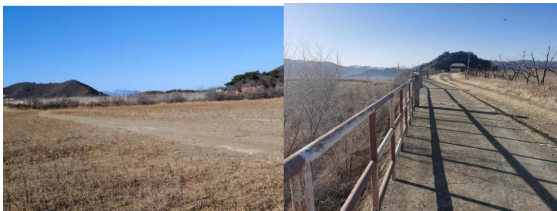
图 2.4-3 和尚峪尾矿库拟建设西副坝位置闭库前现状图
