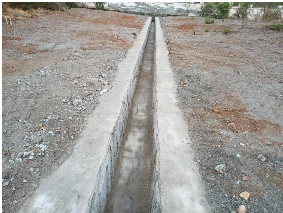
图 2.4-19 坝面纵向排水沟
