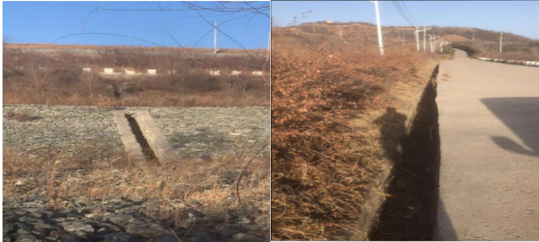
图 2.4-9 排水沟闭库前现状图
