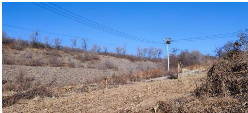
图 2.4-2 和尚峪尾矿库东侧初期坝闭库前现状图
