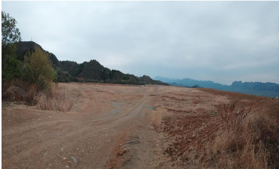
图 2.4-22 滩面修坡及附图区域
