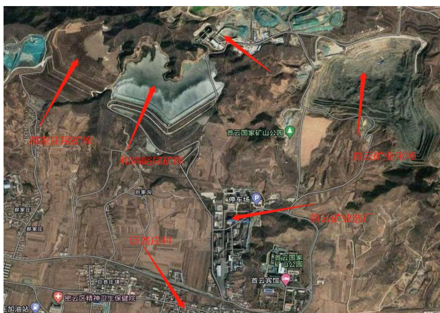
图 2.4-10 尾矿库航拍图
