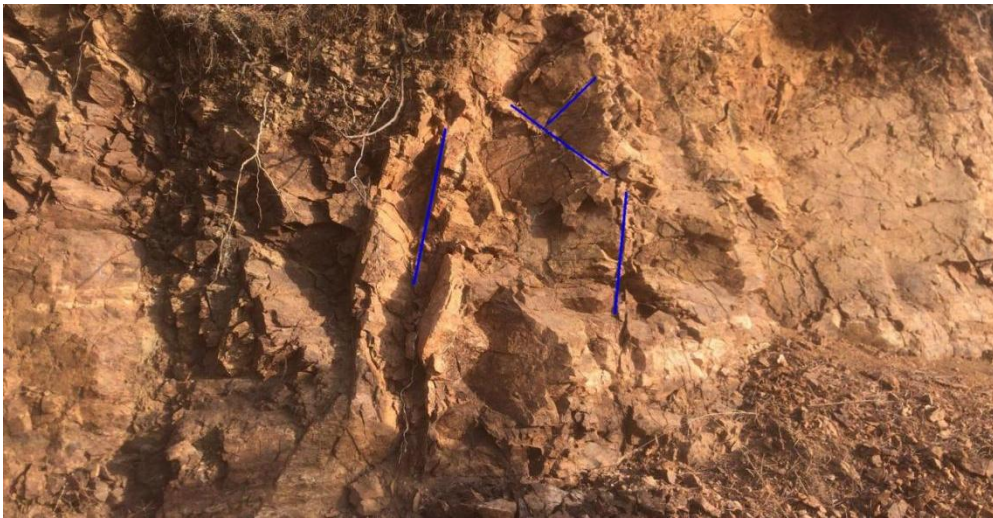
图 2.3-1 节理裂隙现场图
