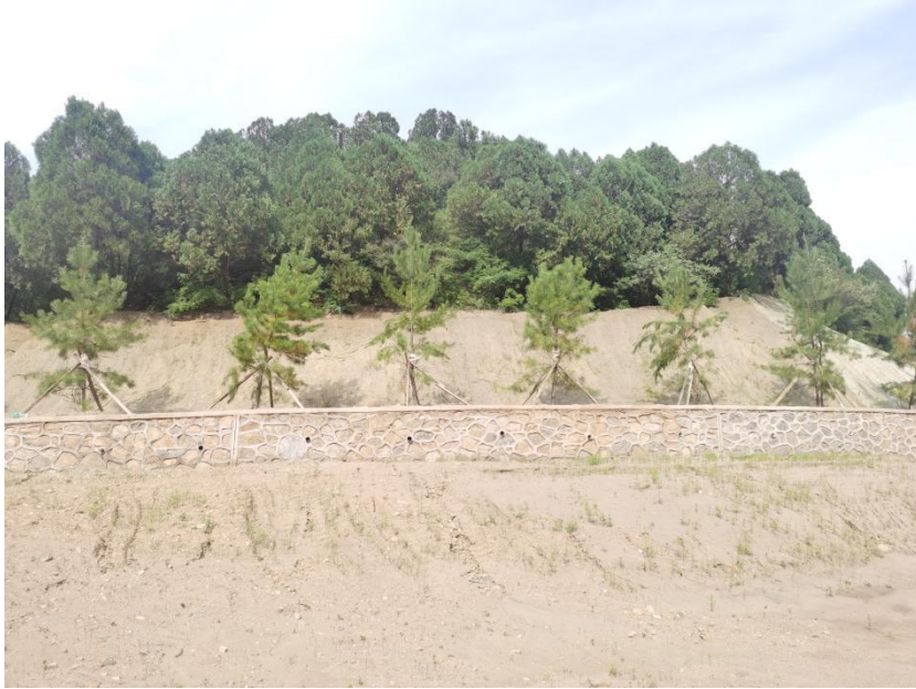
图 2-12 尾矿堆积坝边坡
