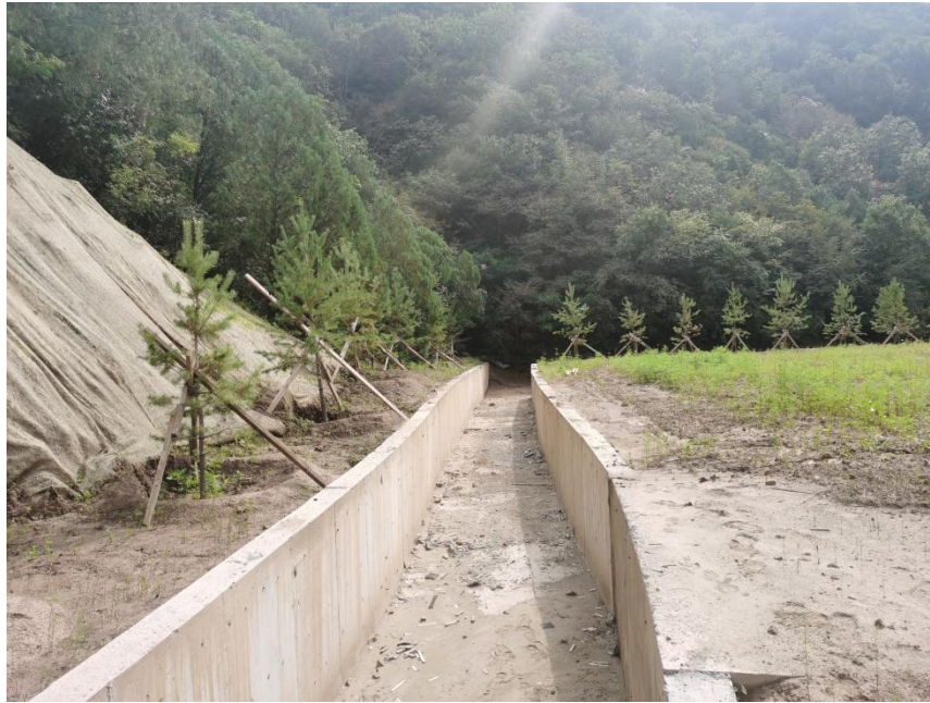
图 2-23 钢筋混凝土排导槽
