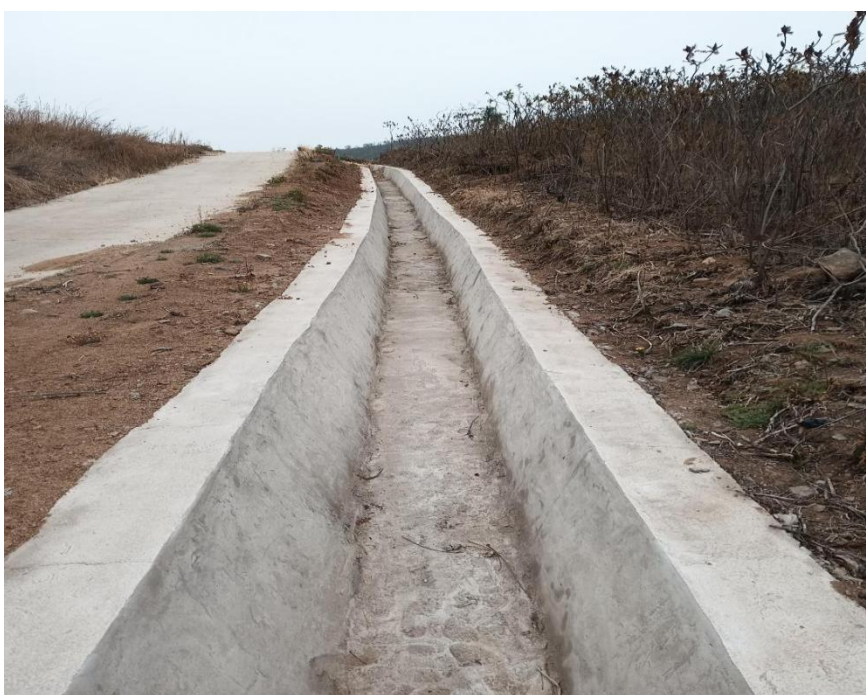
图 2-12 初期坝肩排水沟
