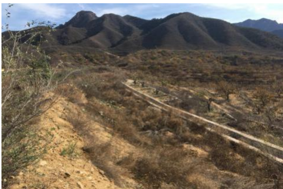
图 2-6 库区南侧坝体外坡（闭库前）
