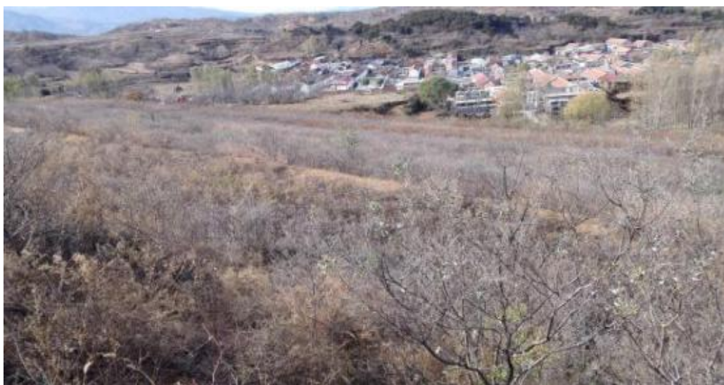
图 2-3 初期坝下游（闭库前）
