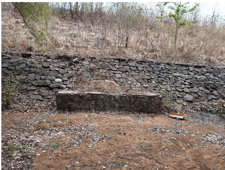
图 2-11 初期坝损坏部位修复
