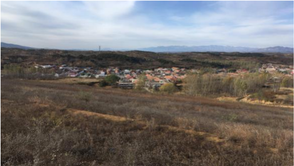
图2-4 坝顶及坝外坡（闭库前）
