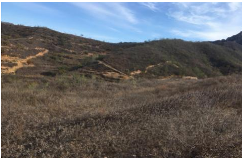
图 2-5 库区北侧坝体外坡（闭库前）
