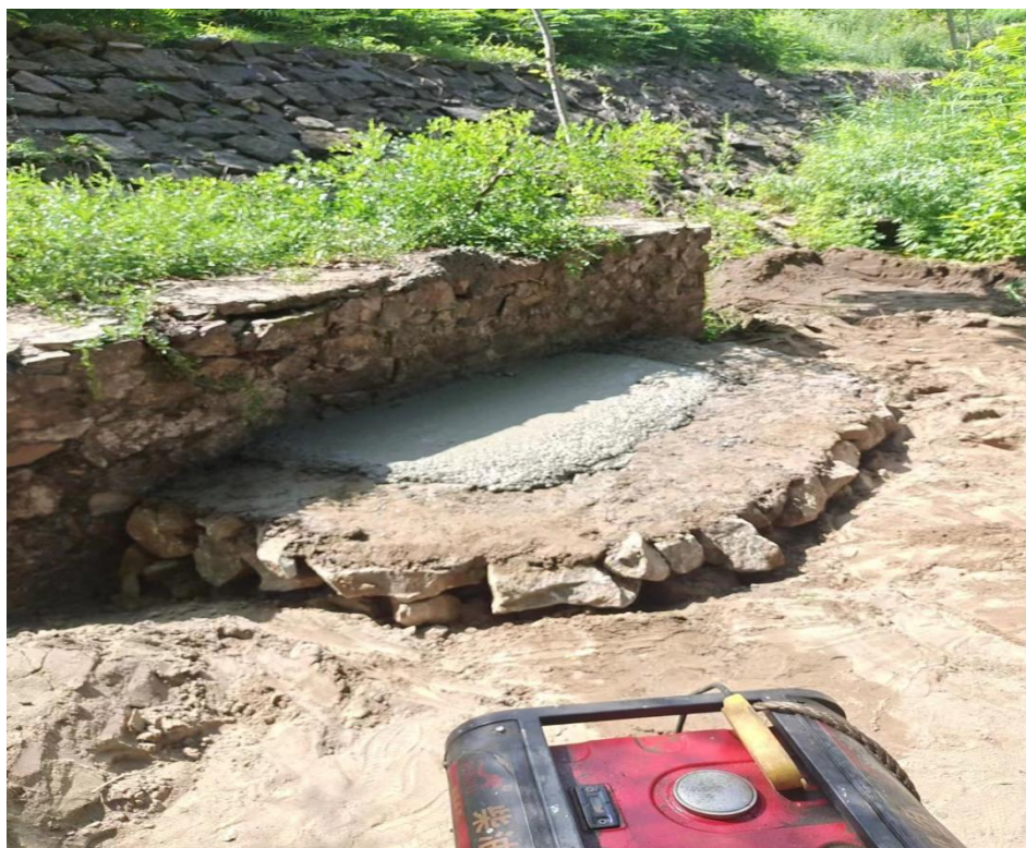
图 2-16 排水管封堵
