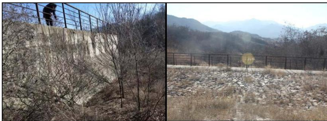
图 2-3 西侧副坝现状
