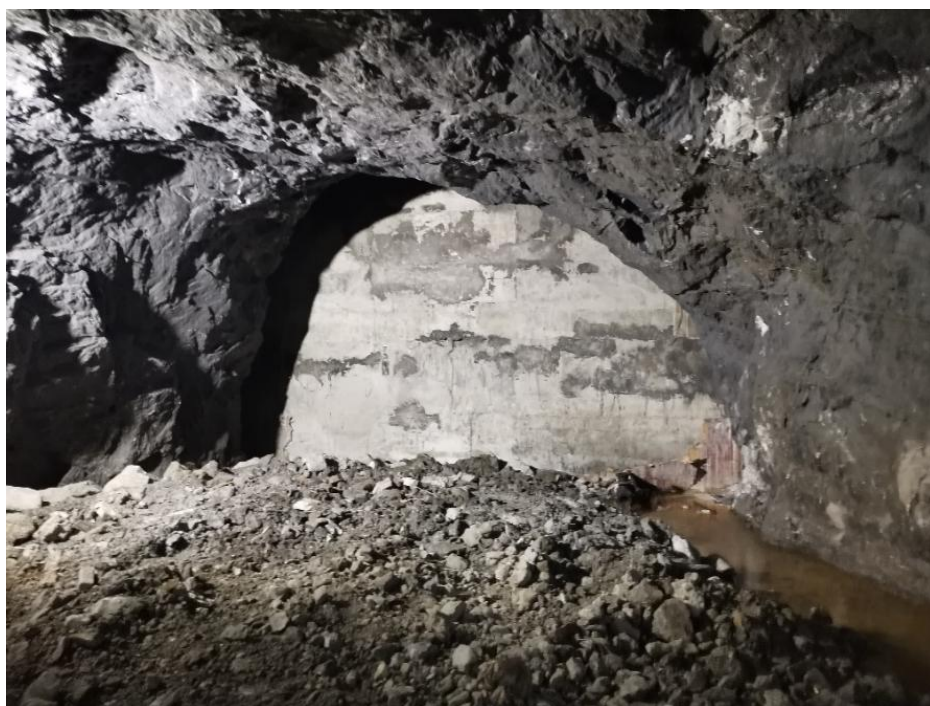
图 3.1-8 铜坑矿与高峰矿长峰大巷封堵情况
