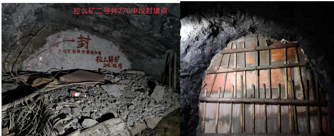
图 3.1-9 铜坑矿与拉么锌矿联通巷道封堵情况
