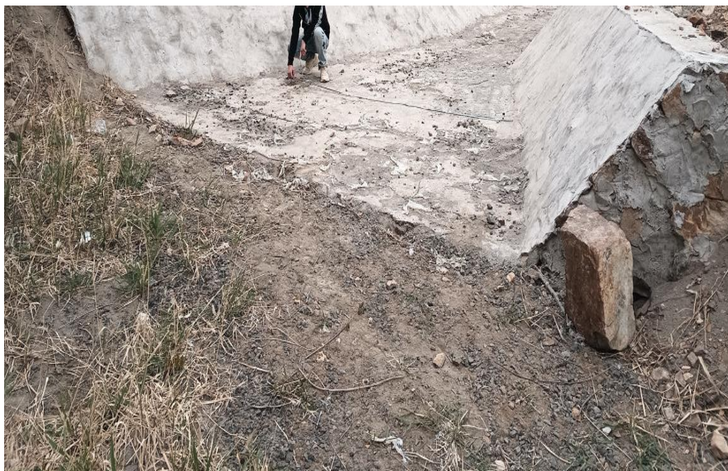
图 2-15 评价组人员现场实测溢洪道尺寸
