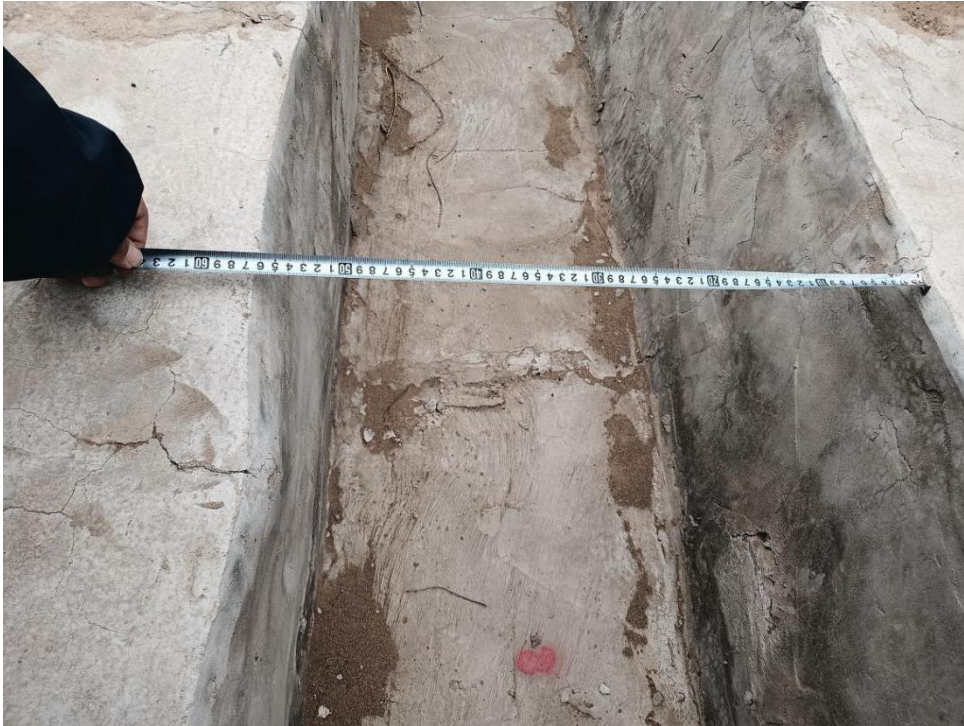
图 2-11 评价组人员现场实测坝面排水沟尺寸
