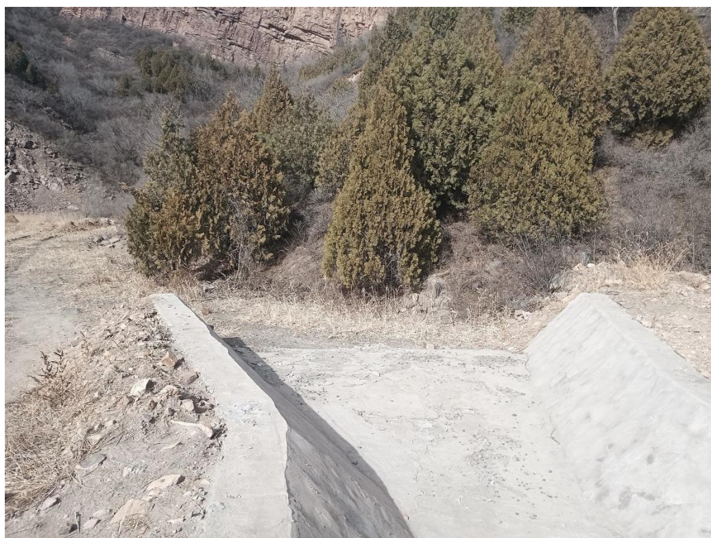
图 2-16 溢洪道进流段
