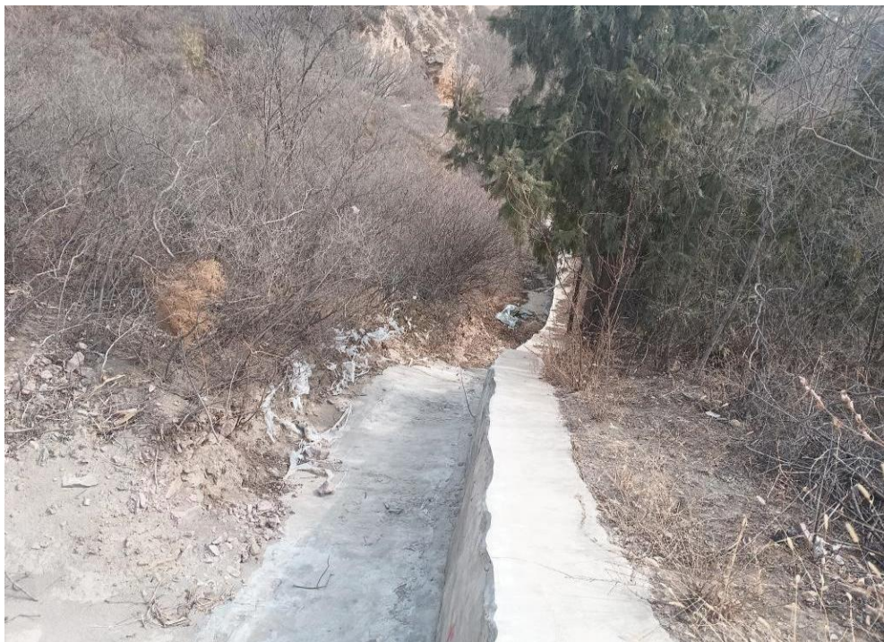
图 2-9 堆积坝坝肩排水沟
