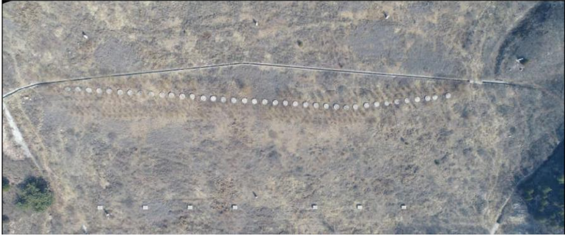
图 2-5 堆积坝外坡虹吸自流排渗井
