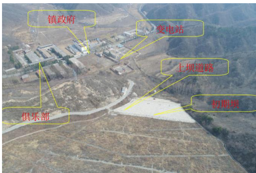
图 2.1-2 尾矿库下游情况航拍图
