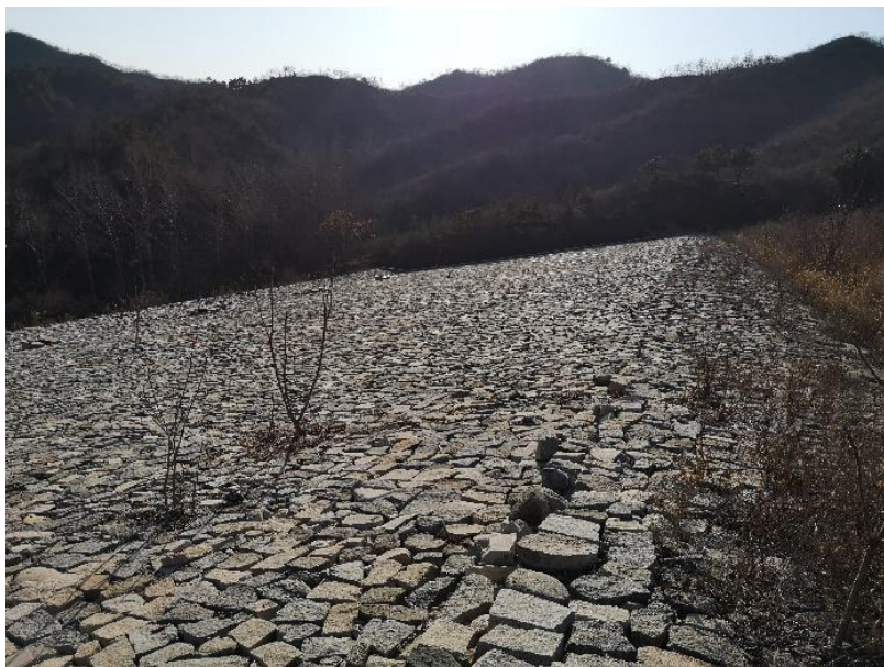
图 2.4-17 贴坡反滤（镜向南）
