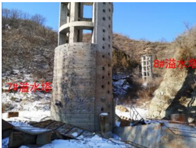
图 2.4-4 溢水塔闭库前现状图
