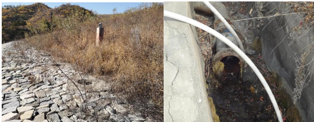
图 2.4-23 虹吸井闭库前现状情况图 2.4-24 堆积坝水平排渗出口管道情况
