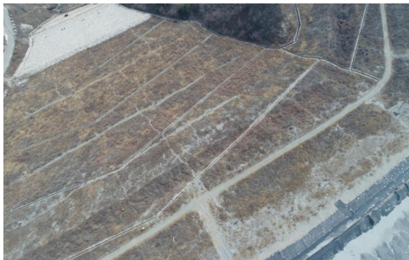
图 2.4-2 尾矿库堆积坝航拍图
