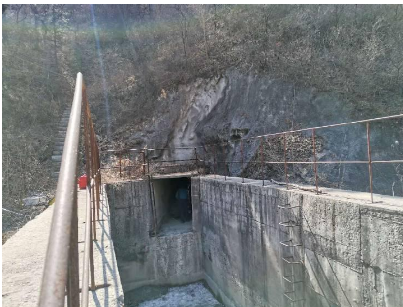
图 2.4-5 隧洞出口闭库前现状
