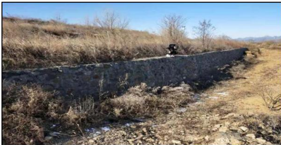
图 2.4-5 东侧道路外挡土墙闭库前现状
