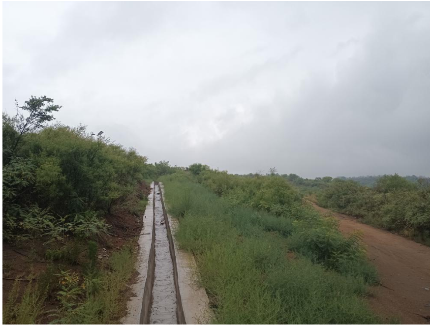
图 2.4-11 新建坝面排水沟
