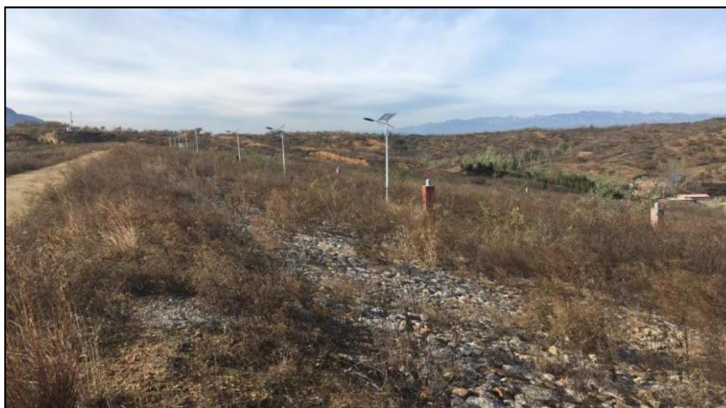
图 2.4-2 尾矿堆积坝坝顶及坝外坡闭库前现状
