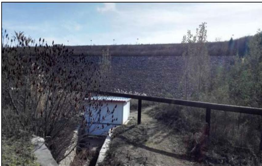
图 2.4-1 初期坝（闭库前）
