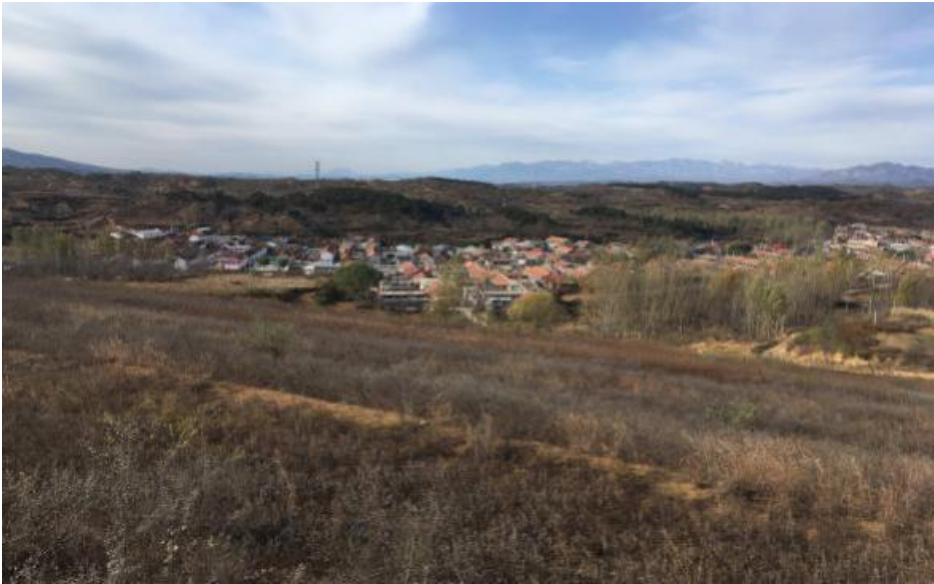
图 2-7 坝顶及坝外坡
