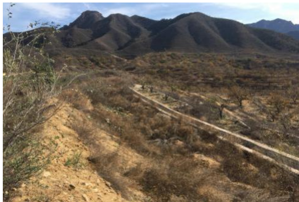
图 2-9 库区南侧坝体外坡
