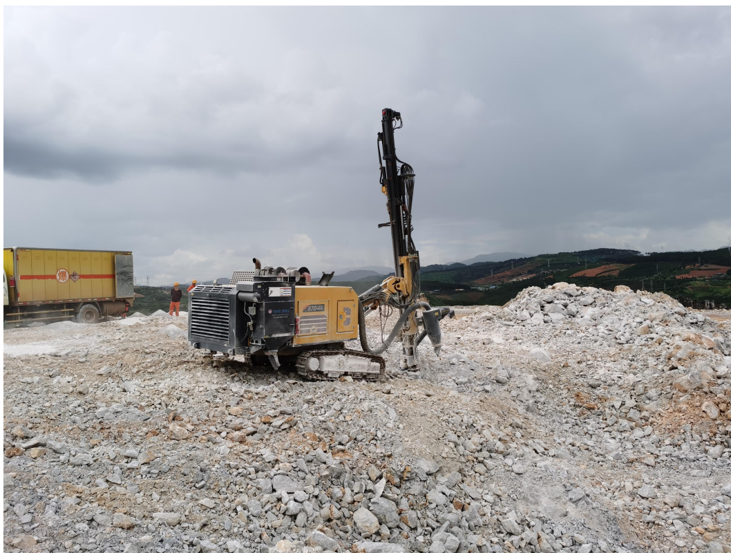
图 2.7-13 潜孔钻机 1457m 平台钻孔
